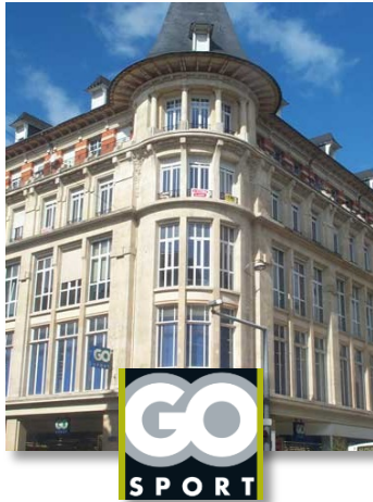
Pied d'immeuble, Reims (51)
