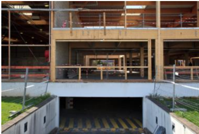
Septembre 2011 – chantier en cours
