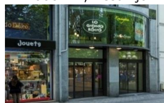
Galerie du Palais, 6 800 m 2 , Tours
