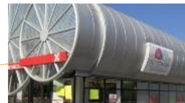
Sud Canal, 11 600 m 2 , St-Quentin-en-Yvelines
