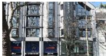
Galerie du Palais, 6 800 m 2 , Tours
