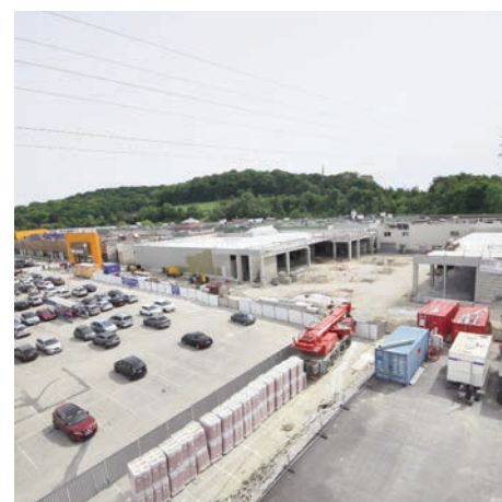
Chantier du centre commercial Valentin, Besançon
