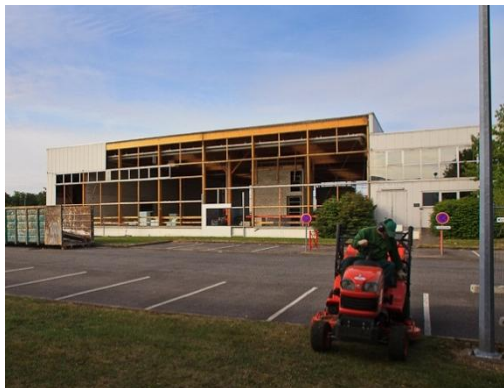
Démolition façade Aquitaine
