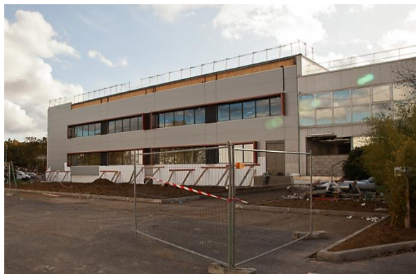
Pose de la nouvelle façade Aquitaine
