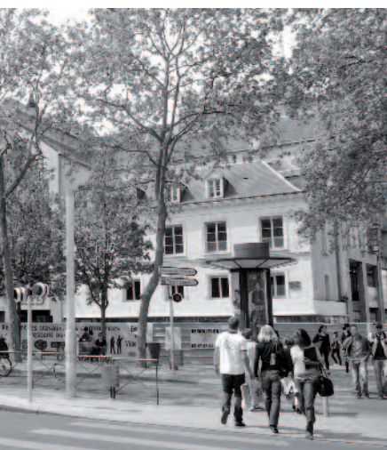
Galerie du Palais en chantier - Mai 2010
